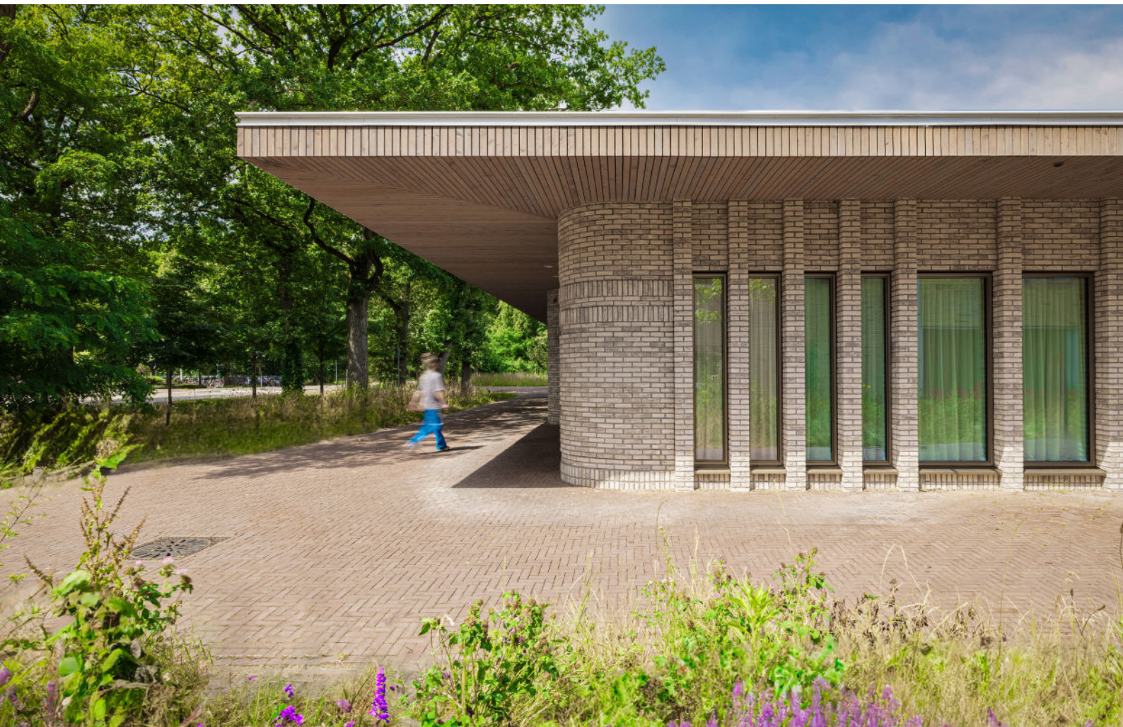
Vakmetselwerk met diepe penanten en terugspringende vensters en houten dakoverstekken
